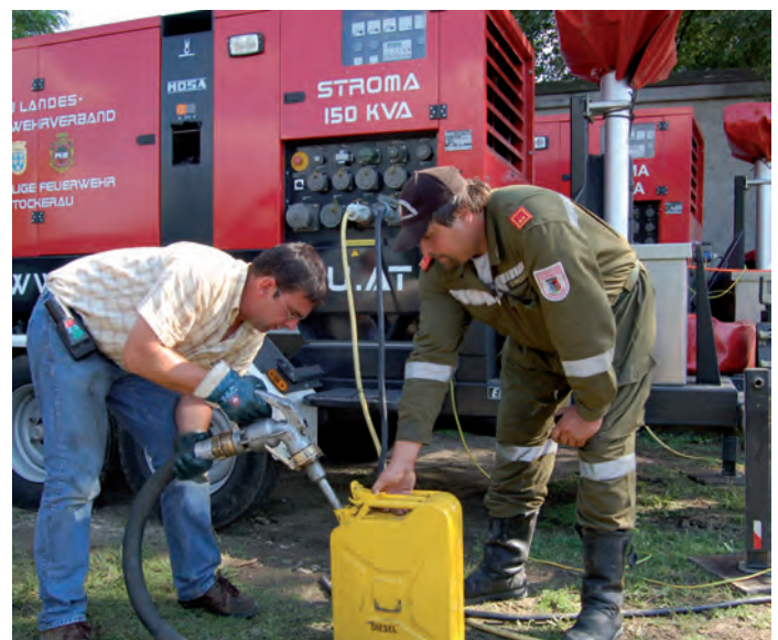
Treibstoffnachschub im Katastrophengebiet - ein Muss für eine erfolgreiche Katastrophenbewältigung: Großaggregate der Feuerwehr im Einsatz beim Pulkau-Hochwasser 2010
