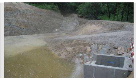
Foto 37: Von den in der Gemeinde geplanten Hochwasserrückhaltebecken wurde 2010 das erste errichtet. Das Ufer ist noch nicht zugewachsen. (Foto: Stadtgemeinde).
