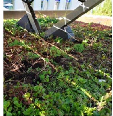
Abb.63: Auflastgehaltene Solaraufständerung mit semitransparenten PV-Modulen
