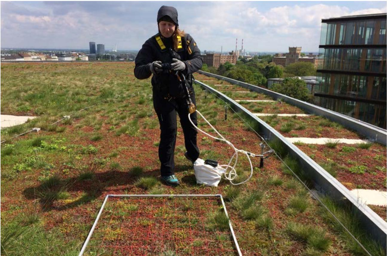
Abb.55: Durch Seilsicherung geschütztes Arbeiten auf dem Dach. Die Vegetation auf einem 2015 fertiggestellten Firmengebäude weist derzeit noch hauptsächlich die gepflanzten Arten auf. Beurteilt werden Vorkommen, Deckungsgrad und aktuelle Entwicklung der Pflanzen.
