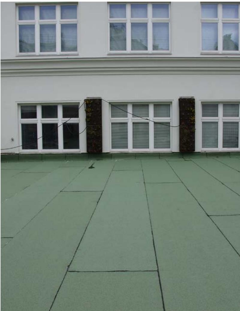
Abb.45: Verlegen der Dachabdichtungsbahn
