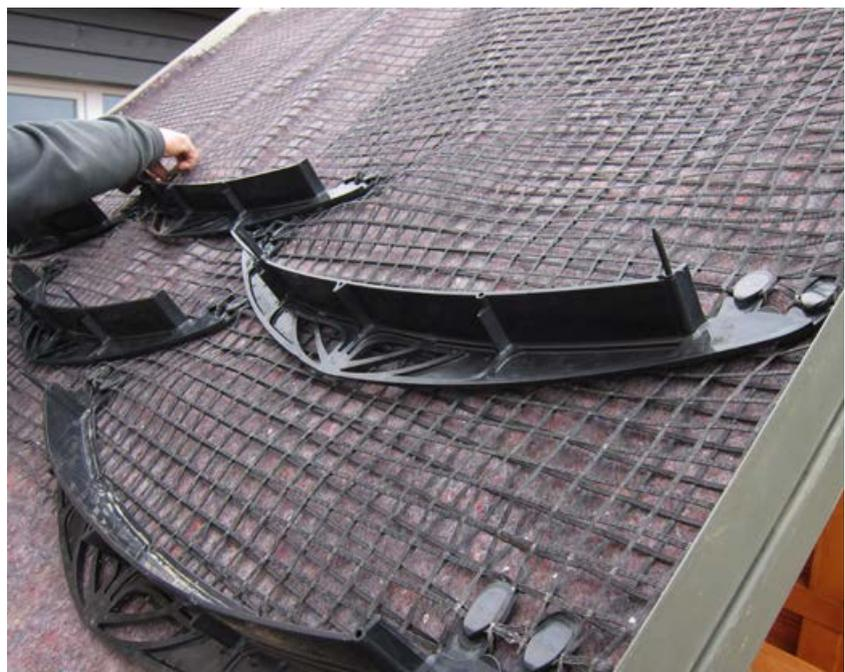
Abb.47: Schubschwellen zur Sicherung des Dachbegrünungsaufbaus auf Steildächern (Quelle: Ulrike Pitha)
