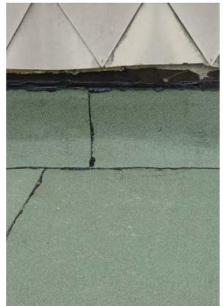
Abb.46: Dachabdichtungsbahn mit hochgezogenen Anschlüssen
