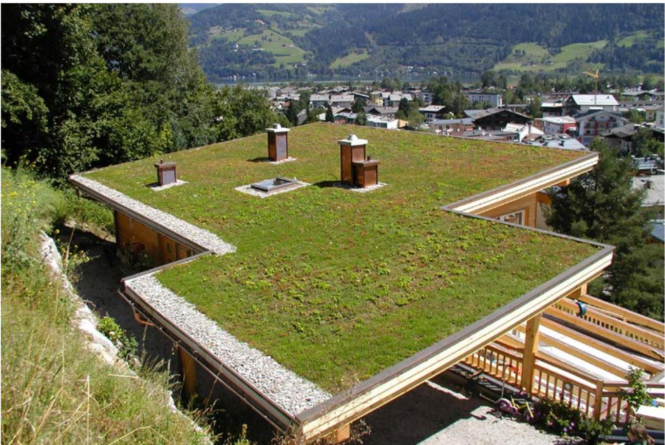
Abb.32: Reduziert extensive Dachbegrünung (Quelle: Dachgrün, VfB)
